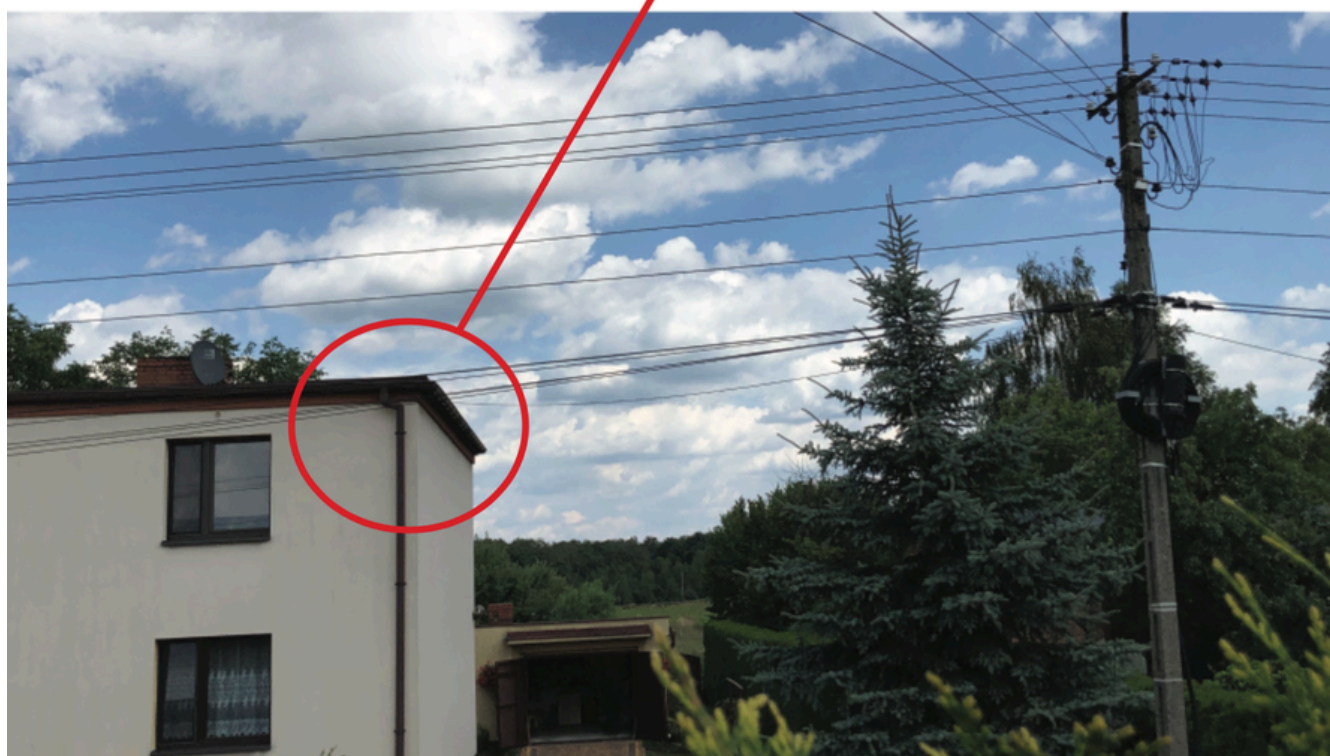
zdj. 5 Montaż światłowodu do elewacji budynku.
