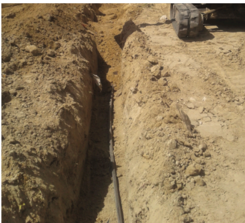
zdj. 3 Wykop z rurą RHDPE.
