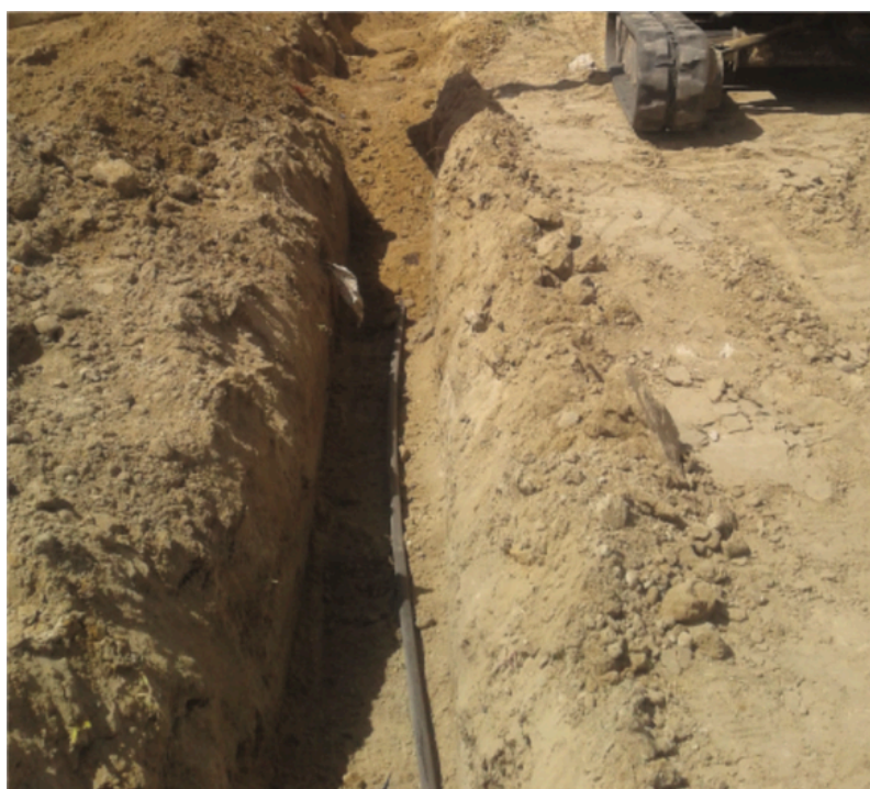
zdj. 3 Wykop z rurą RHDPE.
