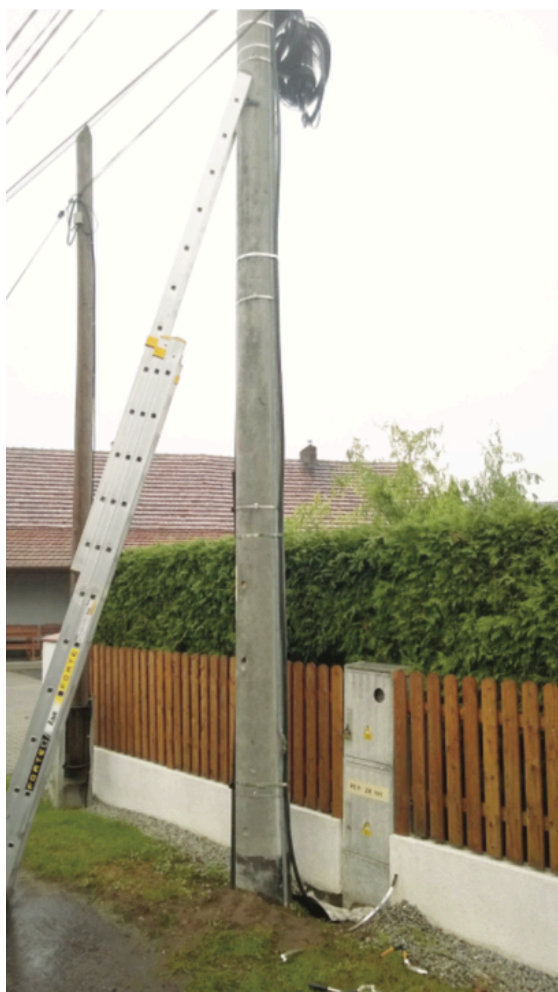
zdj. 1 Montaż rury RHDPE.
