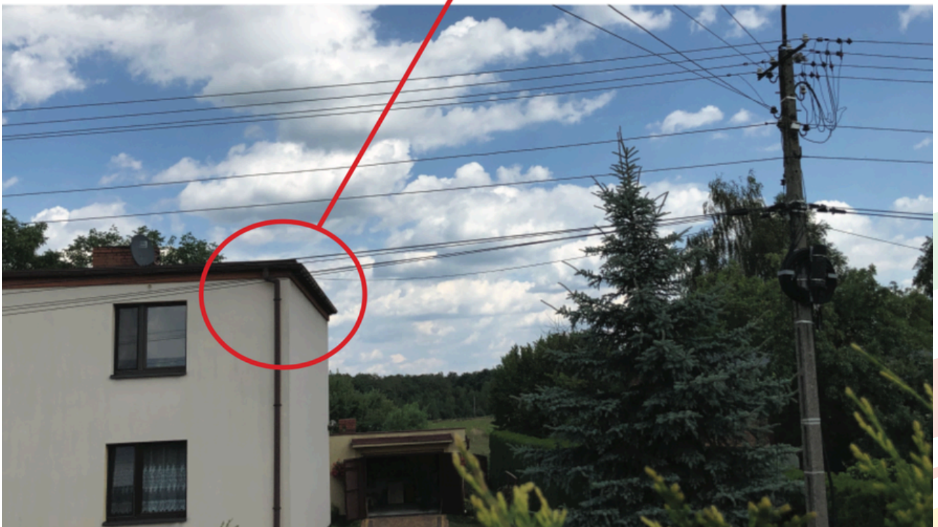
zdj. 5 Montaż światłowodu do elewacji budynku.
